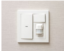
熱感センサースイッチ(玄関)
